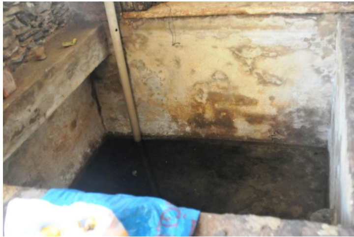
Fotoğraf 4. Derilerin suyunu bırakması için kullanılan su ile dolu havuz
